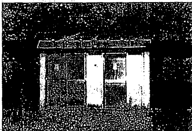
Slika: Trafo stanica
