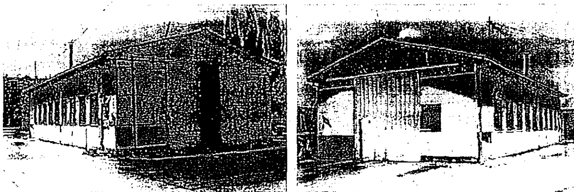
Slike: Objekat tehničke radionice
