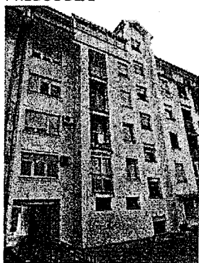
DVORIŠNA FASADA ZGRADE
