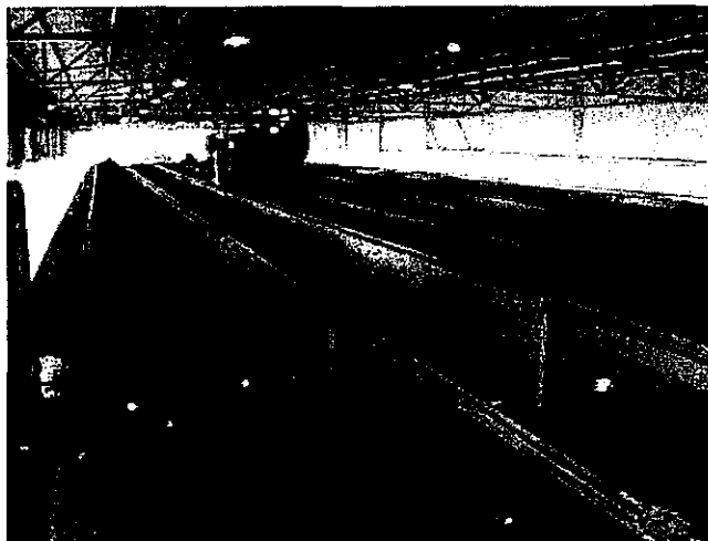
Слика 6.16. Пример постројења за компостирање
