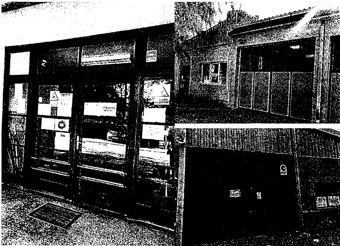
Слика 24. Спољашња врата објекта на к.п. 4829 и 4819
