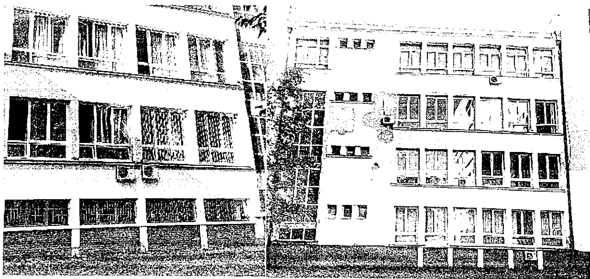
Слика 28. Хлађење помоћу сплит климатизационих уређаја
