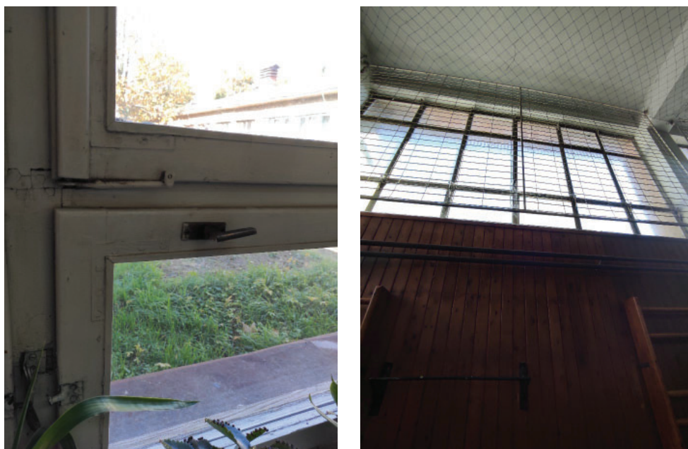
Слика 23. Спољашњи прозори објекта на к.п. 4829 и 4819
