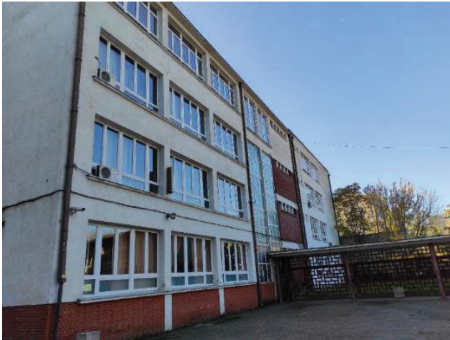
Слика 2. Објекат главне зграде Средње машинске школе – дворишна страна
