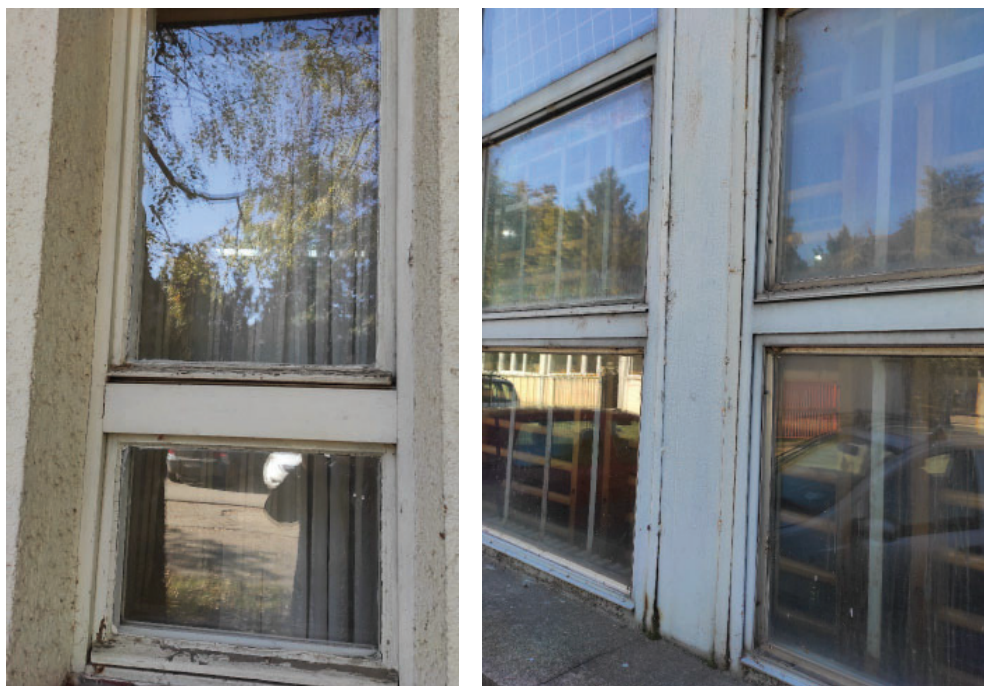
Слика 22. Спољашњи прозори објекта на к.п. 4829 и 4819
