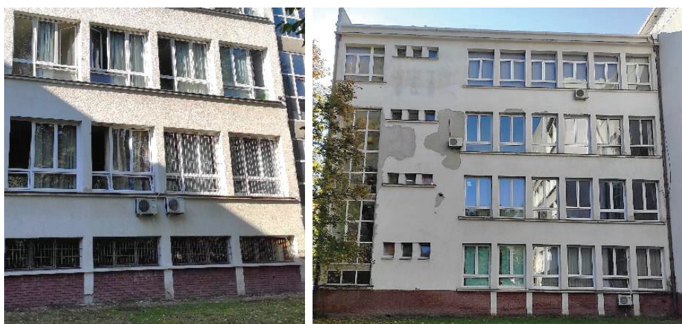
Слика 28. Хлађење помоћу сплит климатизационих уређаја
