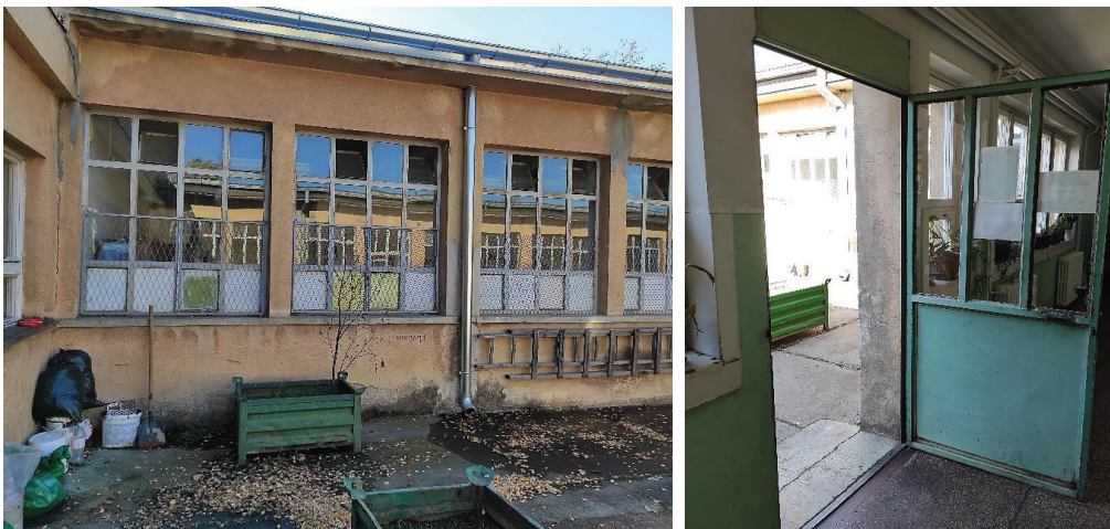
Слика 21. Изглед спољних зидова објекта на к.п. 4829 и 4819
