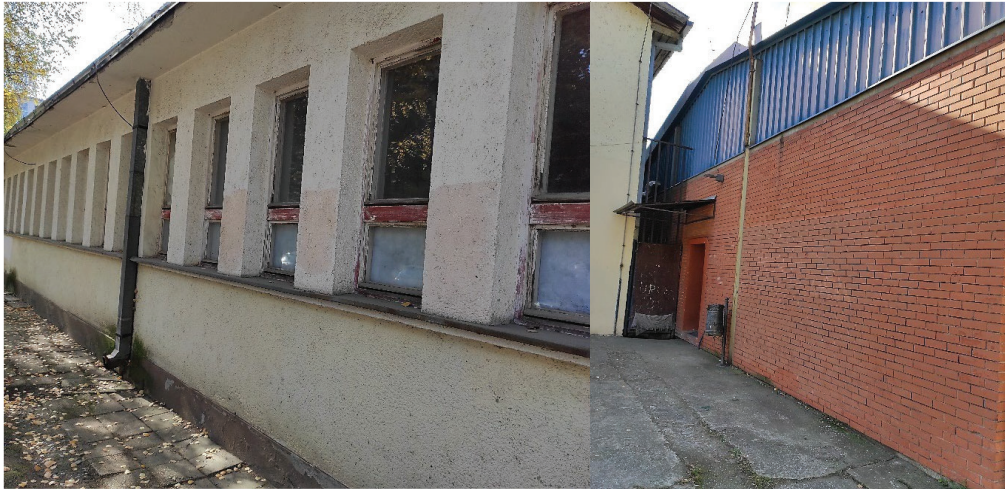
Слика 20. Изглед спољних зидова објекта на К.П. 4829 и 4819
