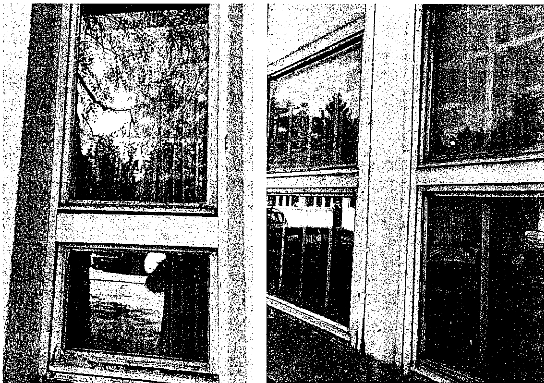
Слика 22. Спољашњи прозори објекта на к.п. 4829 и 4819
