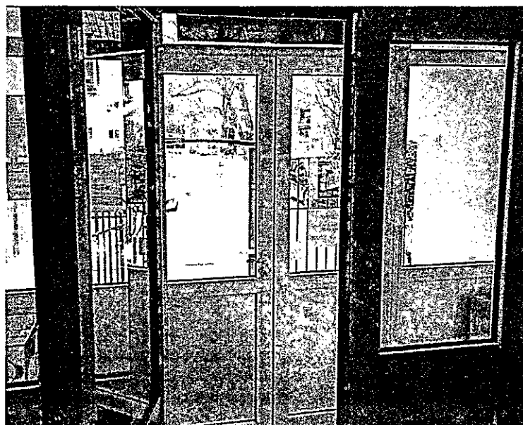
Слика 9. Спољашња ПВЦ врата објекта
