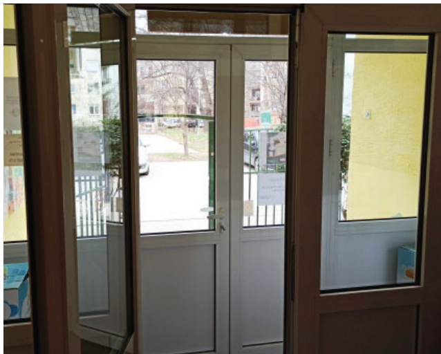
Слика 9. Спољашња ПВЦ врата објекта
