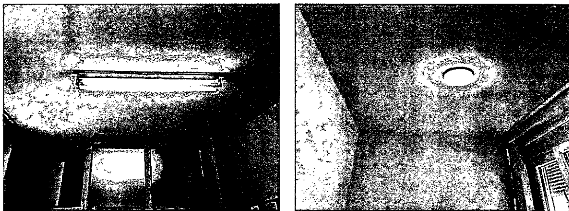
Слика 3 - Типови заступљене расвете, флуоресцентно осветљење и LED
