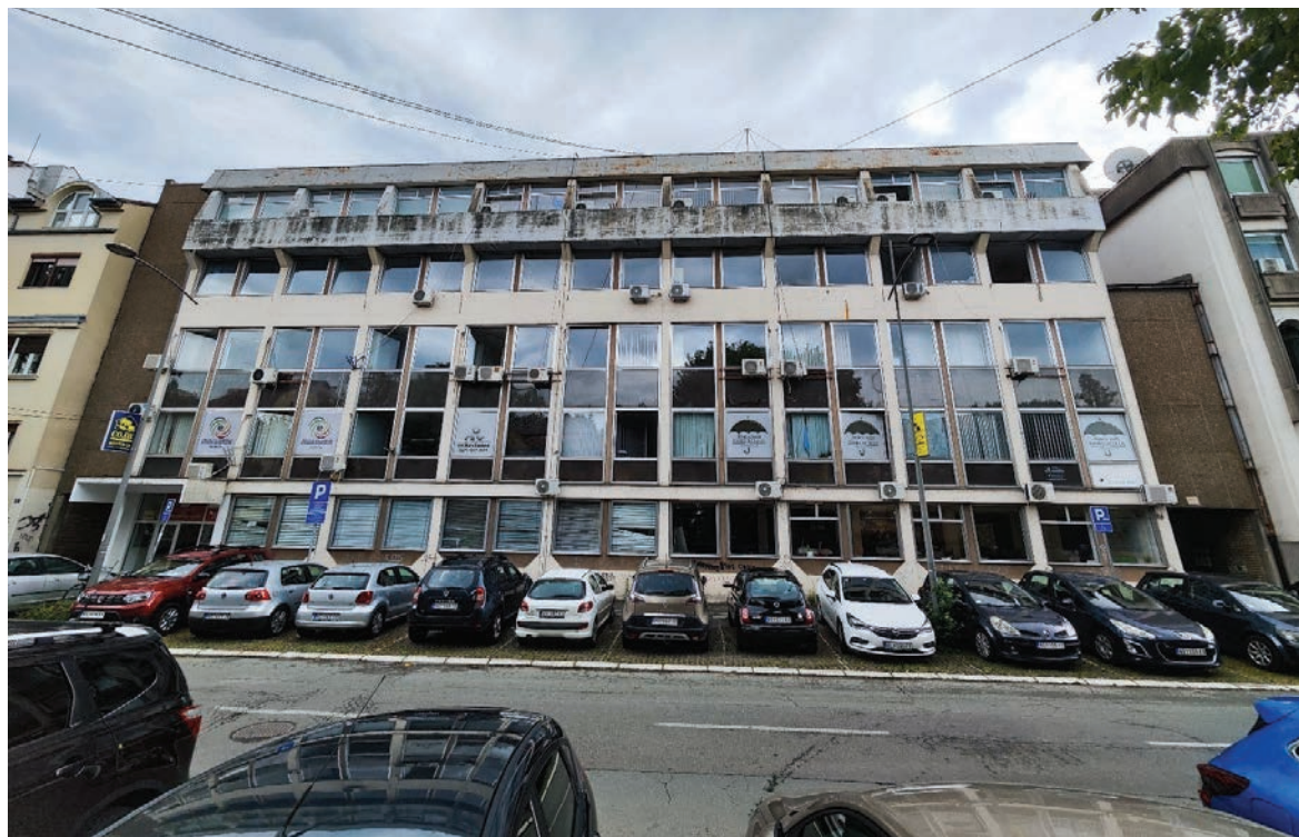
Слика 5 - Изглед спољних зидова објекта
