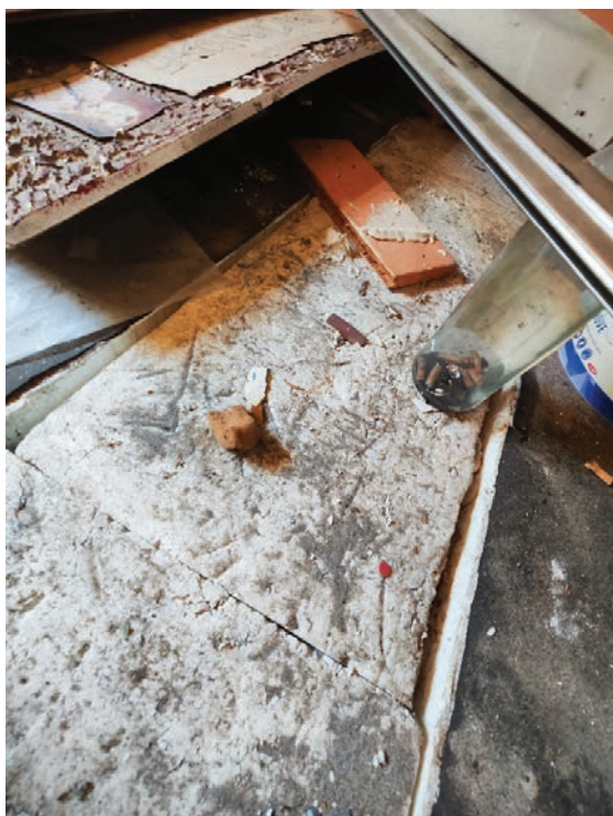
Слика 7 - Изглед међуспратне конструкције испод негрејаног простора
