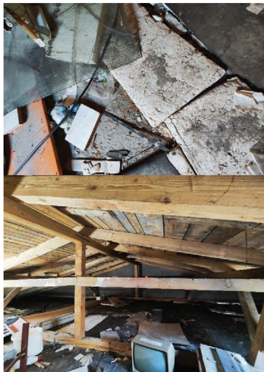
Слика 7 - Изглед међуспратне конструкције испод негрејаног простора
