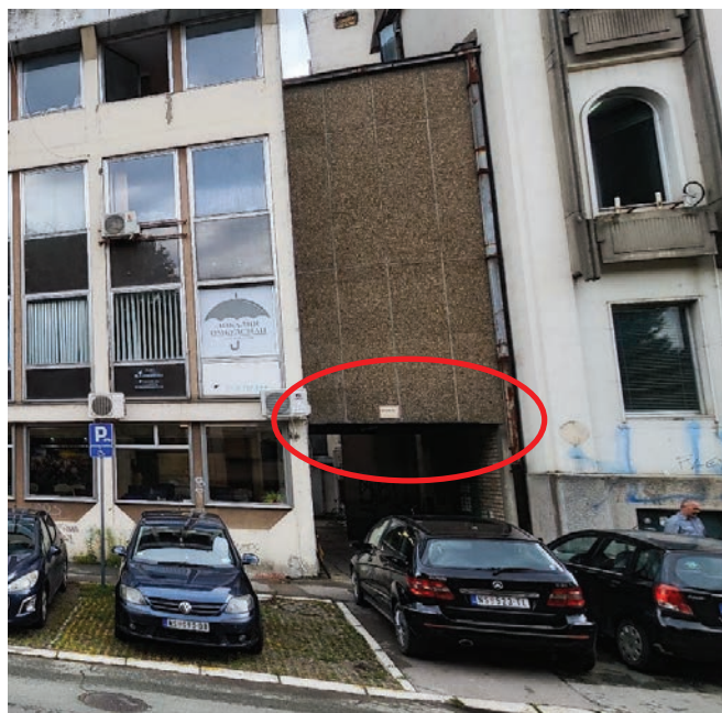
Слика 8 - Изглед међусpratне конструкције изнад спољног простора
