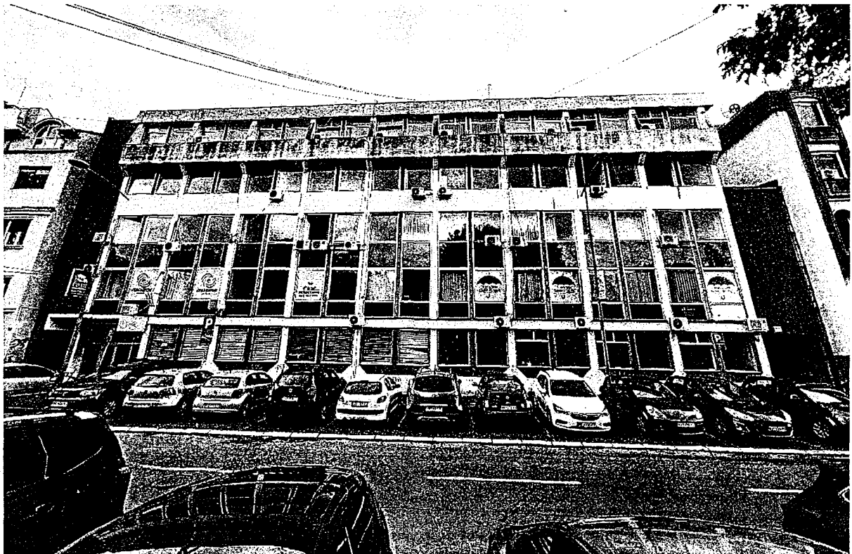
Слика 5 - Изглед спољних зидова објекта
