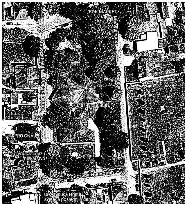
Слика 2 - Локација објекта (извор: Google Maps )
