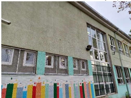
Слика 0.1 – Изглед фасадног зида
