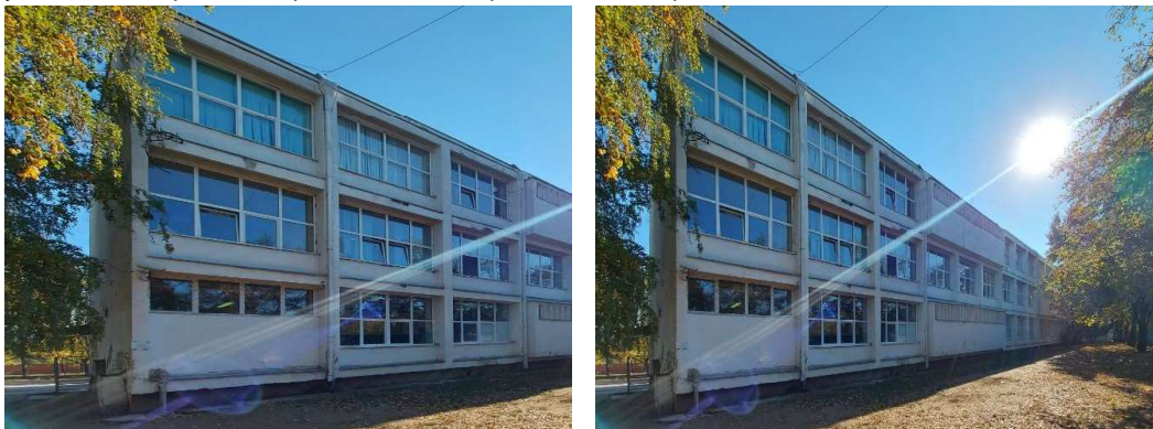
Слика 0.1 – Изглед фасадног зида
