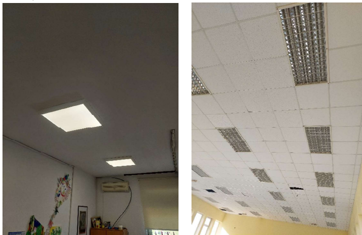
Слика 0.8 – Типови осветљења LED-лево и флуоресцентно-десно
