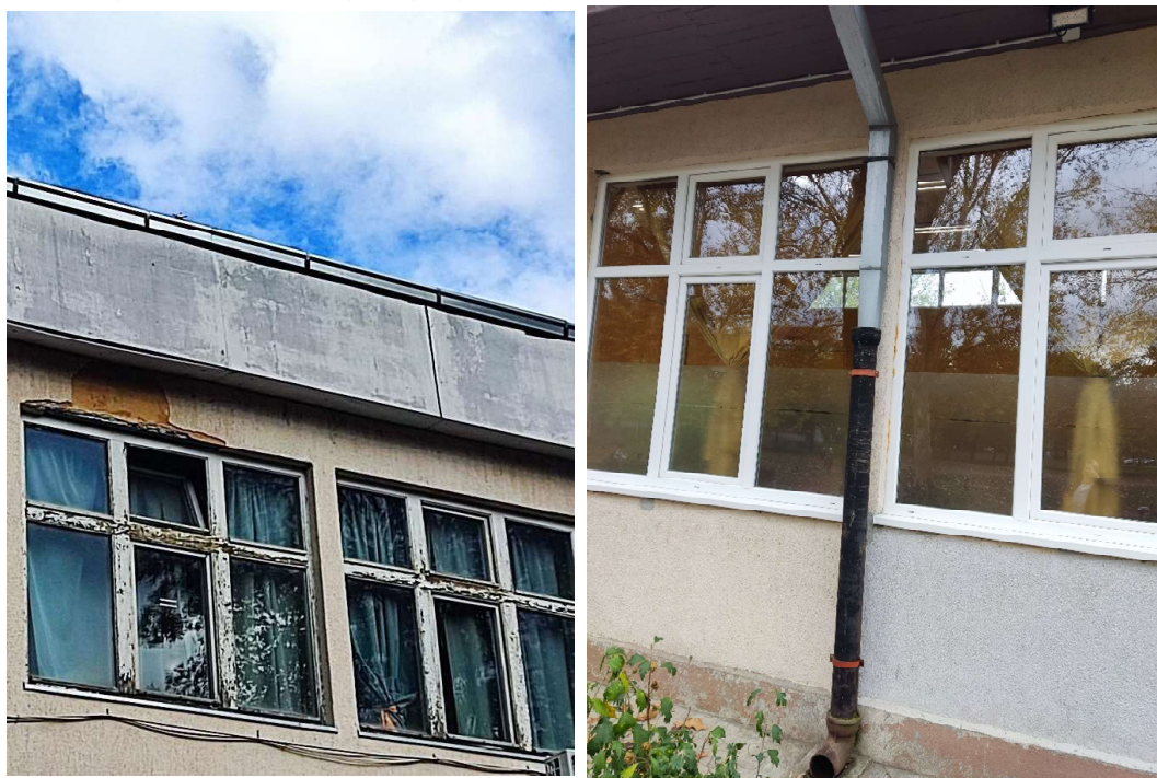
Слика 0.4 – Изглед спољашње дрвене и ПВЦ столарије
