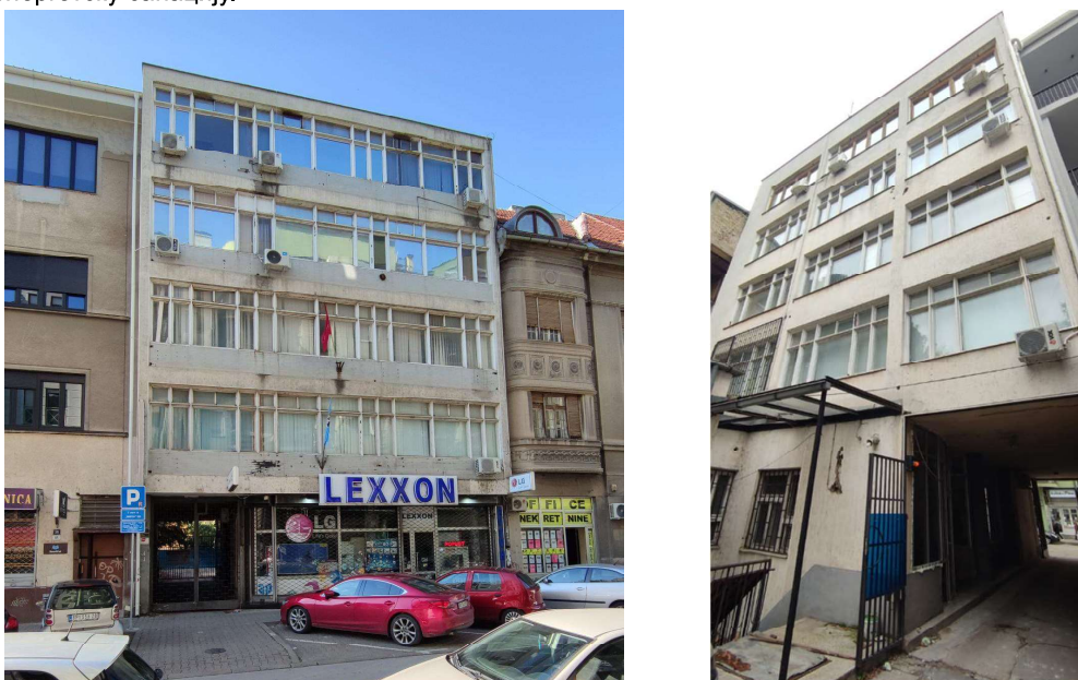
Слика 0.1 – Изглед фасадног зида
