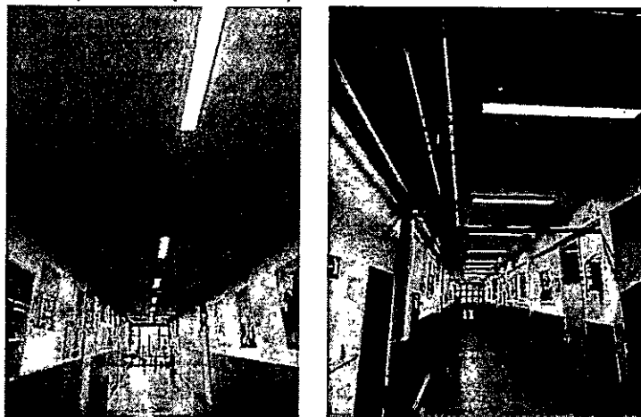
Слика 0.6 –LED расвета унутар објекта
